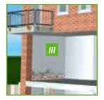
L'humidité montante dans les murs occasionne des dégâts importants avec entre autres une cristallisation saline, des plâtres tombants, des papiers peints moisis et des champignons nocifs. Grâce à un procédé patenté, par exemple au moyen d'une injection sans pression, on insère dans le mur une résine synthétique durable et imputrescible. De cette façon on obtient un étanchement horizontal durable empêchant l'humidité capillaire de monter.
